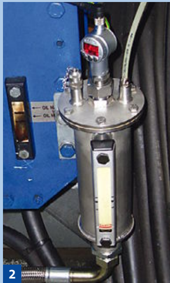
Ölpumpensensor für mehr Sicherheit.
