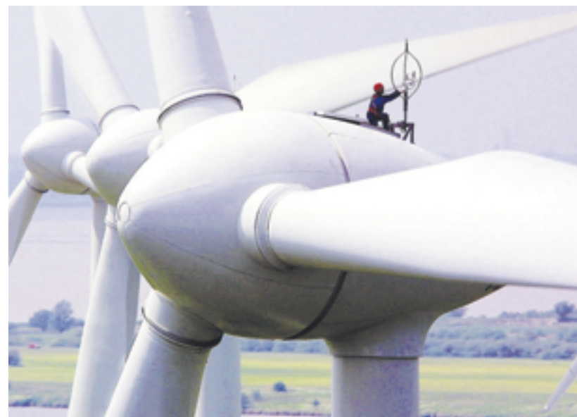
Nichts für schwache Nerven: Ein Windkrafttechniker justiert ein Windmessgerät auf einem Windkrafttrahnen in 67 Metern Nabenhöhe. FOTO: DPA
